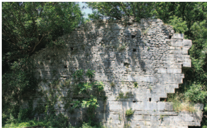
Fig. 3 Ponte Latrone (Capriati a Volturno, CE), spalla orientale del ponte con restauri medioevali.
